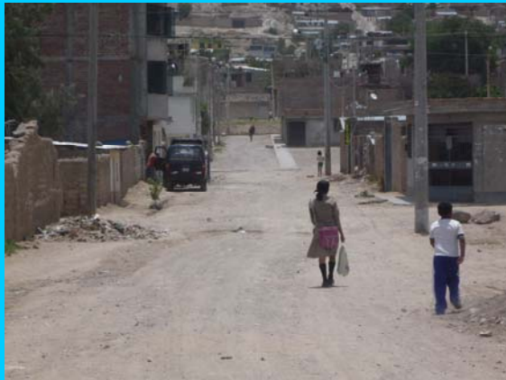
Construcción de Pistas y veredas en el AAHH Covadonga - Programa las Calles de mi
