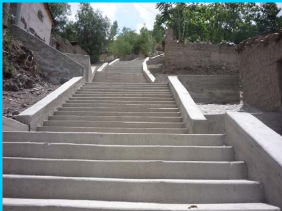
Construcción Graderías Cabuyales de Cuchipampa en el distrito de Avacucho -
