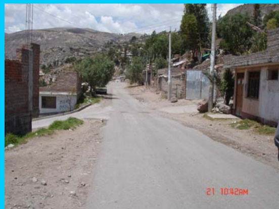
Construcción de pistas y veredas en el Jr. Cesar vallejo y Jr. Túpac Amaru del
